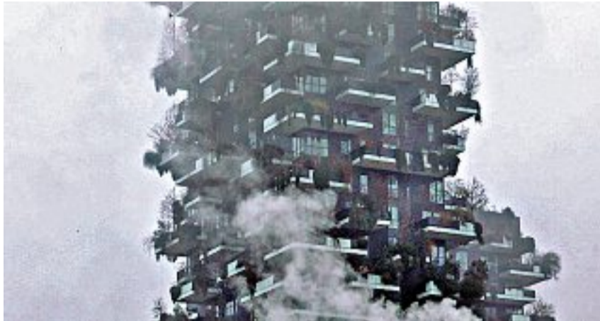
Assedio Fumi e nebbie avvolgono le torri dei Giardini verticali, nell'area di Porta Nuova
